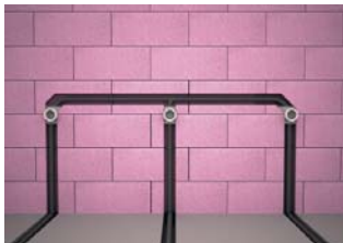
Fig.17 - Exemplo de roços abertos numa Alvenaria Leca® Bloco
