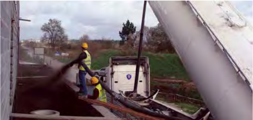
Figura 39 Bombagem de Geo Leca® para o tardoz de um muro (Estação de Alfarelos, Soure).
