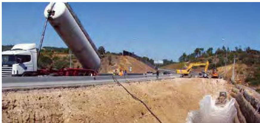
Figura 38 Descarga de Geo Leca® a partir de cisterna no tardo de um muro de gabiões (IC9, Tomar).
