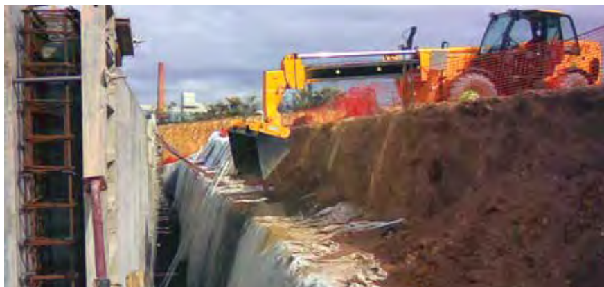
Figura 37 Geo Leca® no tardo de um muro de suporte na Zona Industrial de Avintes (Gaia).
