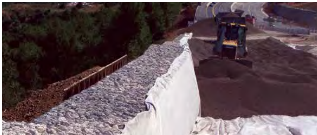
Figura 28 Aterro com Geo Leca® confinado lateralmente por gabiões (A16, Cascais).
