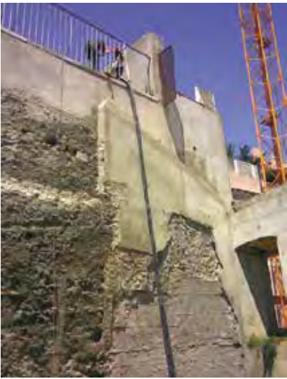
Figura 40-a e 40-b Fornecimento de Geo Leca® a partir de cisterna na zona do Chiado (Lisboa).
