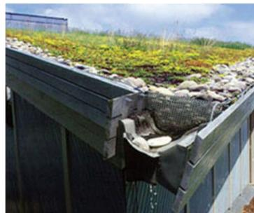
Fig.42 – Exemplo de sistema de drenagem de águas pluviais numa cobertura ajardinada (Fonte: <http://www.igra-world.com>)
