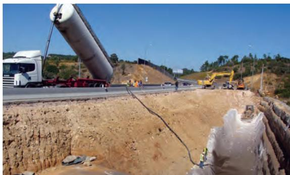
Figura 38 – Descarga de Geo Leca® a partir de cisterna no tardo de um muro de gabiões (IC9, Tomar)
