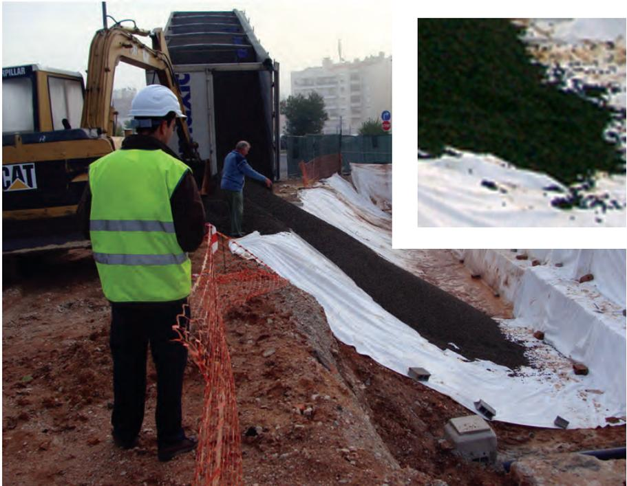
Figura 36 – Utilização de Geo Leca® na reabilitação do muro de gabiões que suporta o parque de estacionamento junto à Embaixada dos EUA (Lisboa)
