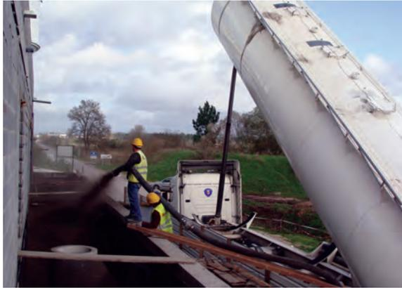
Figura 39 – Bombagem de Geo Leca® para o tardo de um muro (Estação de Alfarelos, Soure)
