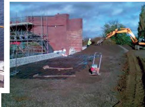
Figura 34 – Aterro com Geo Leca® reforçado com geogrelhas nas margens de uma albufeira
