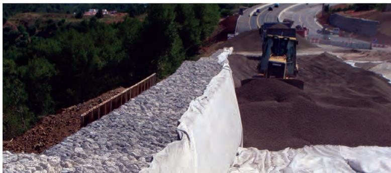
Figura 28 – Aterro com Geo Leca® confinado lateralmente por gabiões (A16, Cascais)
