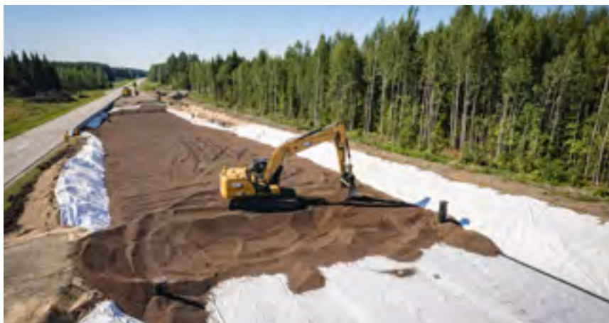
Camada de agregados leves Leca® com 1,3–3,3 m, envolvida em geotêxtil.
