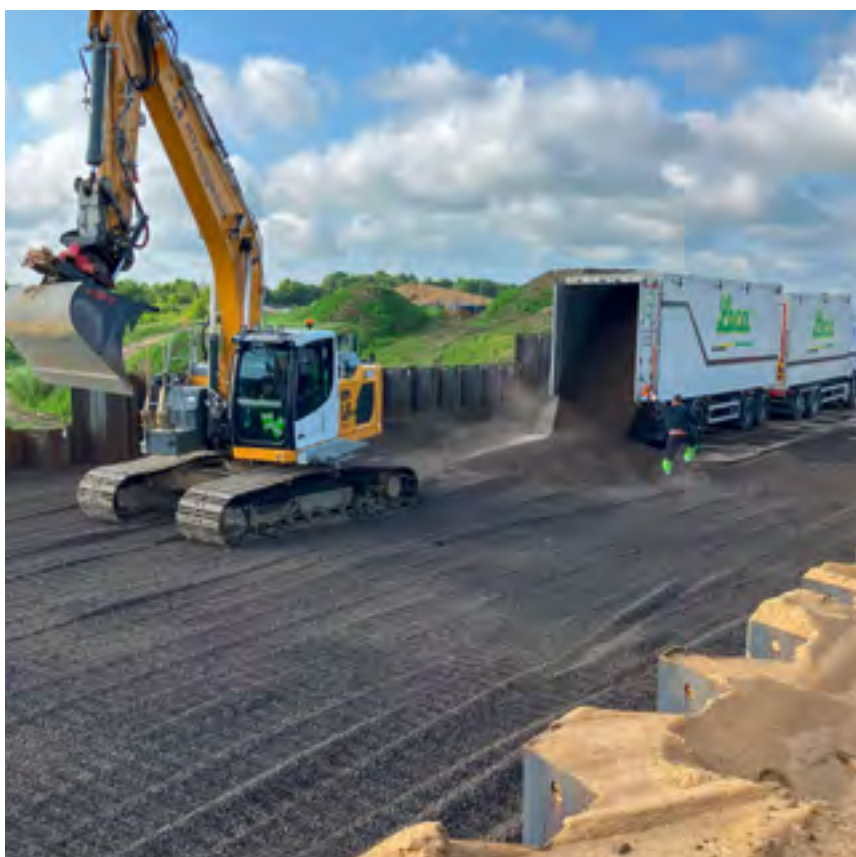
Agregados leves Leca® a serem aplicados na autoestrada E45 reduzindo a carga e a pressão de terras na estrutura rodoviária.
