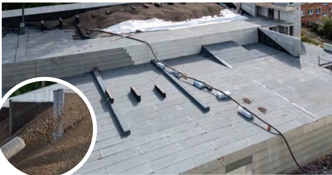
Os agregados leves Leca® foram fornecidos através de transporte pneumático
