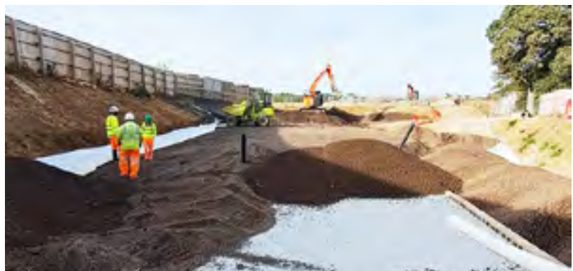
Mais de 5.600 m 3 de agregados leves Leca® foram utilizados para suportar a extensão do aqueduto antes do início dos trabalhos de terraplenagem.
