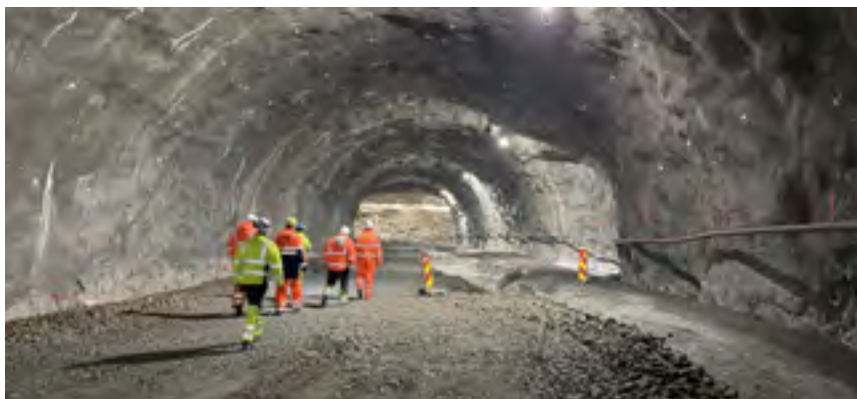
Equipa de projeto no local, no túnel de Brattfjell.
