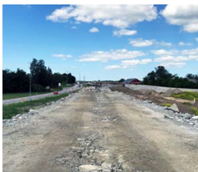
Terraplenagem para a nova rodovia, que melhorará a capacidade e a segurança para os 15.000 veículos que ali circulam diariamente.
