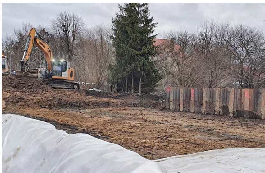
Foi construída uma proteção da coroa do leito ferroviário sob a forma de uma estrutura de contenção feita de uma parede de estacas de chapa de aço com ancoragem seccionada.
