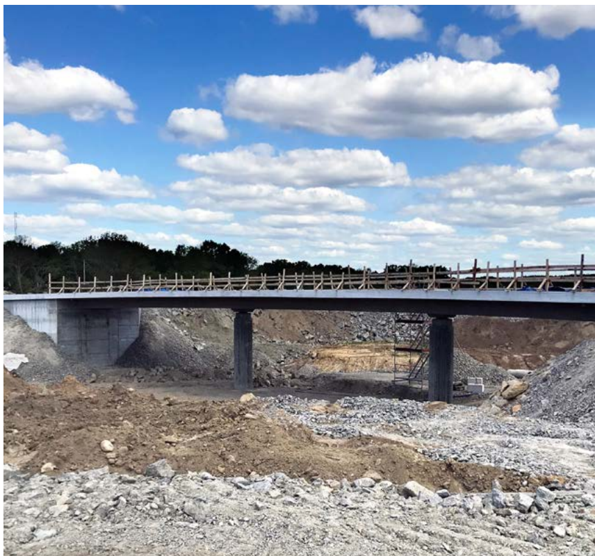
Uma das 23 pontes que estão a ser construídas para melhorar a infraestrutura, onde o agregado leve Leca® evita a necessidade de mais estacas.
