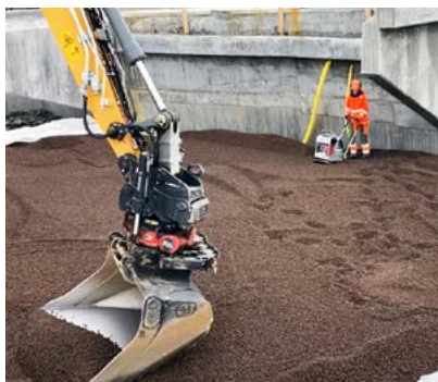
Uma escavadora espalha LWA Leca, essencial para fazer face a desafios geotécnicos na estrada de Lösen-Jämjö.
