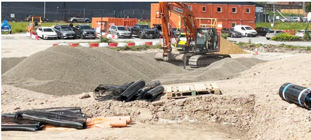
Foram utilizados 3.000 m 3 de agregados leves Leca® nos muros de suporte de uma nova passagem pedonal elevada.
