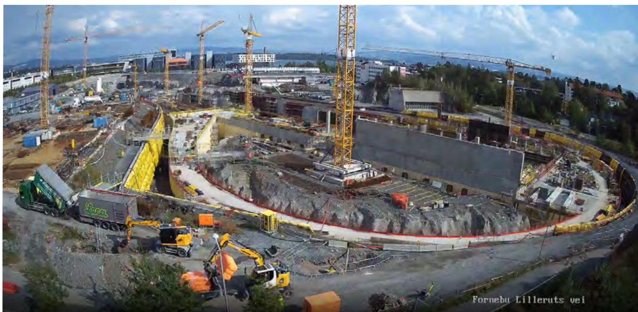
Os agregados leves Leca® são aplicados por insuflação, reduzindo os impulsos de terras sobre as estruturas da nova estação de metro de Fornebu, em Oslo
