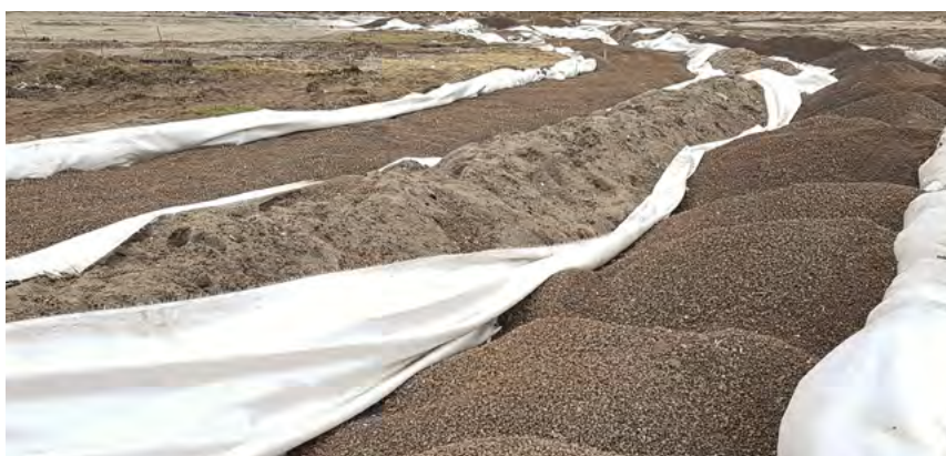
Os agregados leves Leca® compactados (8/10–20 mm), confinados em geossintéticos, constituem «colchões de agregados leves» concebidos para reduzir as cargas aplicadas ao terreno de fundação.
