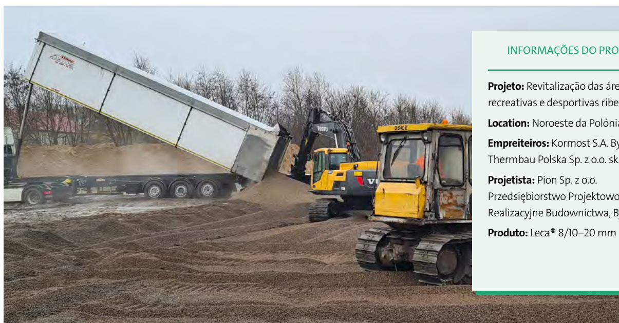
O fornecimento dos agregados leves Leca® em camiões basculantes permitiu uma instalação rápida e eficiente diretamente no local da obra.
