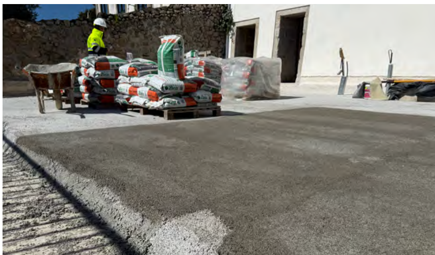
O terraço com vista para o rio Douro - onde na imagem é visível o Leca® Mix - será o centro das áreas de lazer do hotel.
