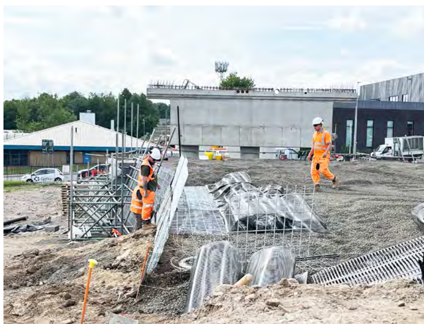
Foi necessário utilizar um material de enchimento leve para reduzir o risco de assentamentos e as cargas transmitidas aos encontros da ponte.
