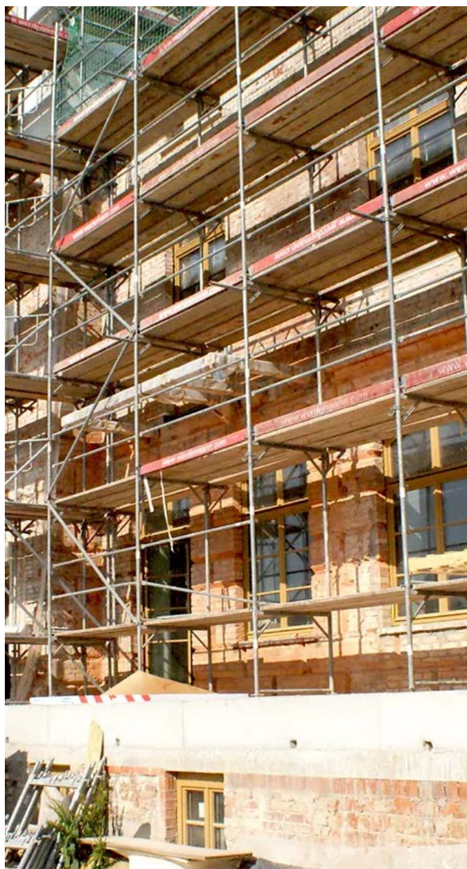
Edifício em construção
