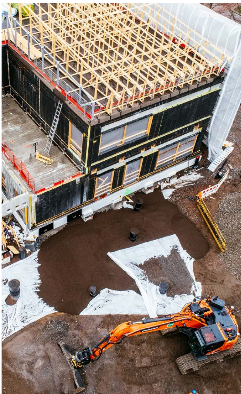
Foram utilizados mais de 2.000 m 3 de agregados leves Leca ® nos enchimentos da Escola de Puotila.
