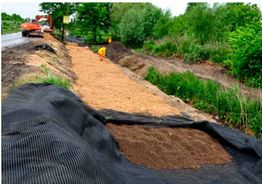
Cobertura do enchimento e criação de sub-base para o pavimento
