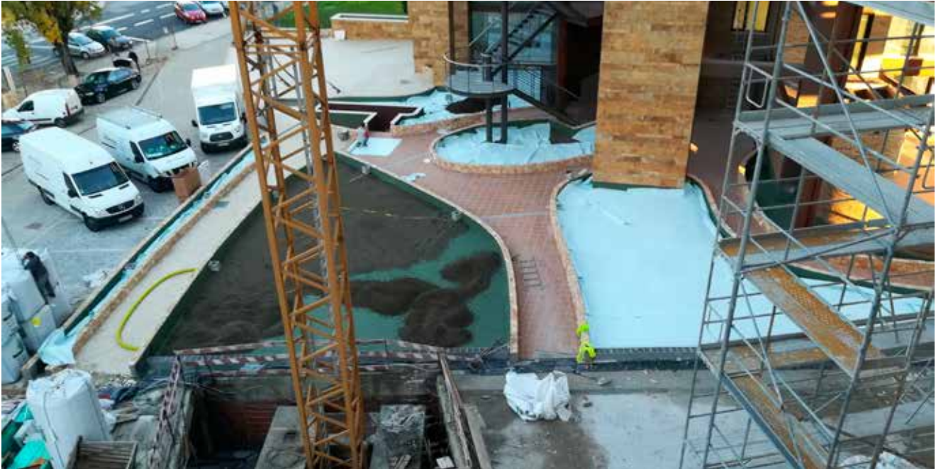
Foram aplicados neste projeto 400 m 3 de agregado Leca, entregues em sacos e big bags
