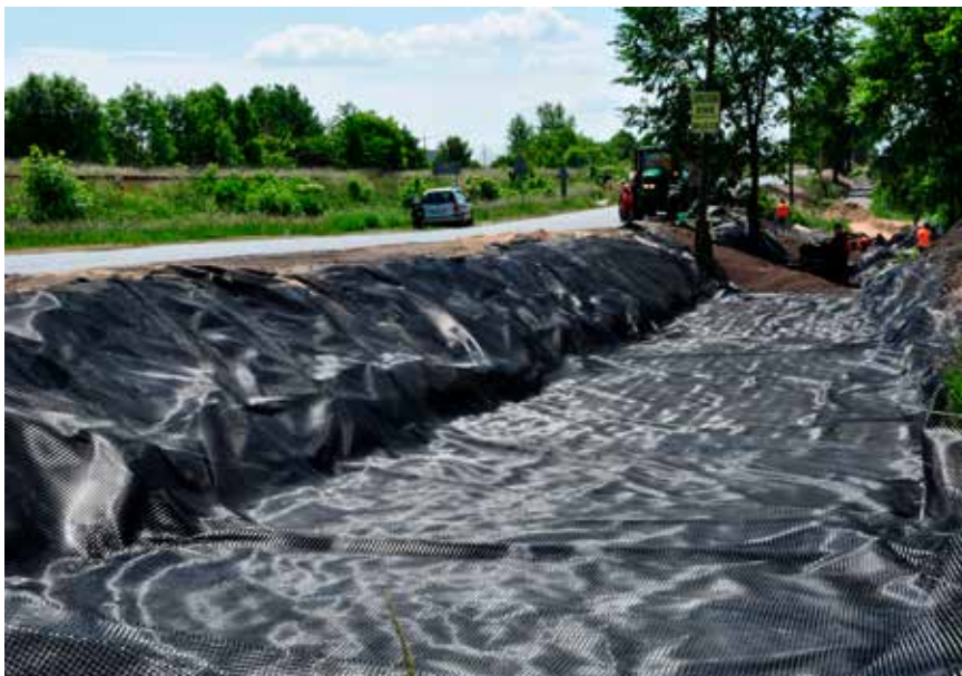
Aplicação de manta de geotêxtil
