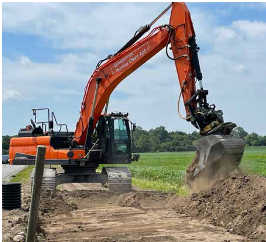
Foi necessário remover apenas cerca de 10 cm de material orgânico
