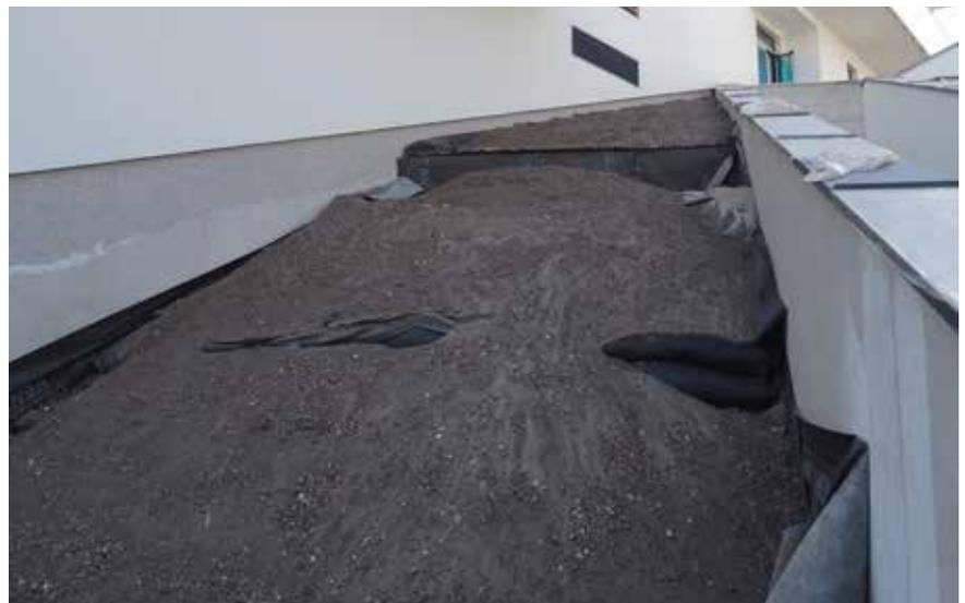
**Taludes** criados com “colchões” de argila expandida
