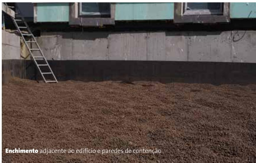
**Enchimento** adjacente ao edifício e paredes de contenção
