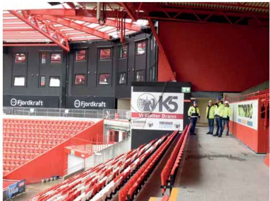
**A parede divisória acima** foi feita com Isoblokk 25 de Leca, rebocada e pintada com a cor do Brann. Da esquerda para a direita: Hans Økland, gestor de obra da Constructa e diretor de operações no departamento de alvenaria da empresa; Knut Bjørkheim, gestor distrital da Weber para a região oeste; Arild Polden, consultor de vendas da Bygg Engros AS; e Knut Bjørkheim, representante de vendas da Leca Noruega.
