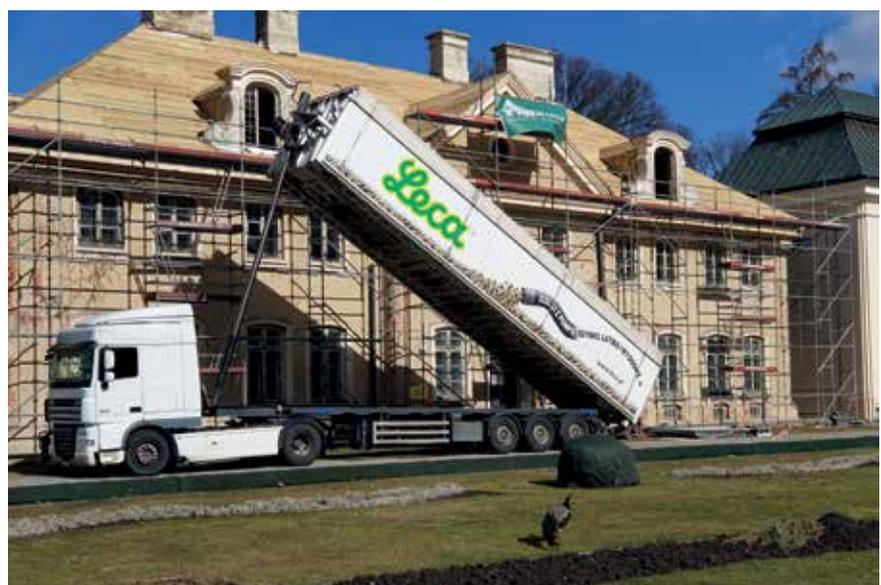
Veículo com bomba pneumática para entrega do agregado leve.
