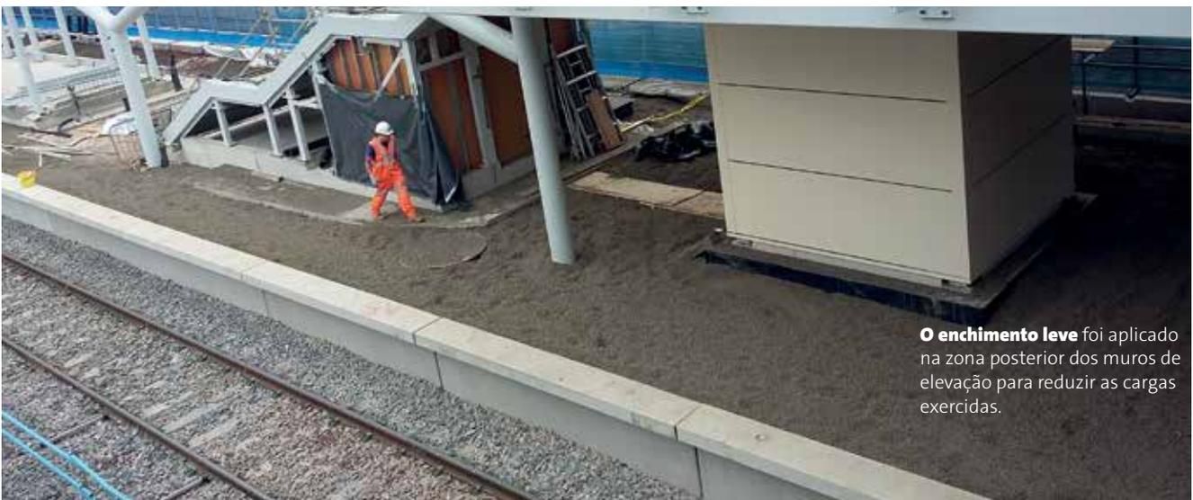
**O enchimento leve** foi aplicado na zona posterior dos muros de elevação para reduzir as cargas exercidas.
