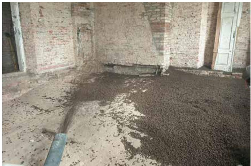
Aplicação do agregado leve com recurso a bomba pneumática.
