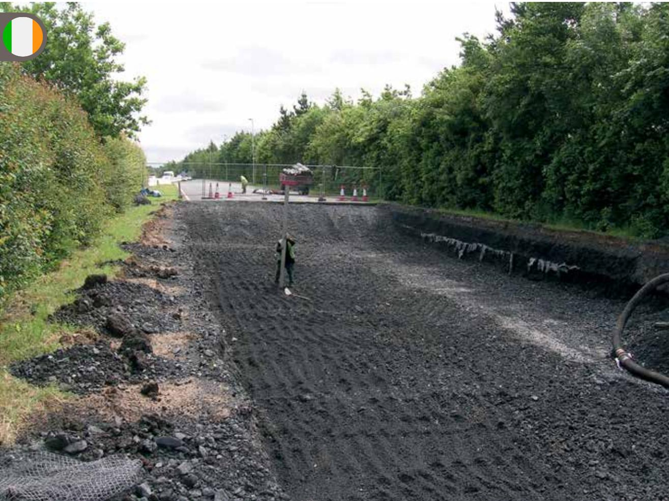
O agregado leve Leca® substituiu o material pesado que tinha sido usado na construção da estrada.
