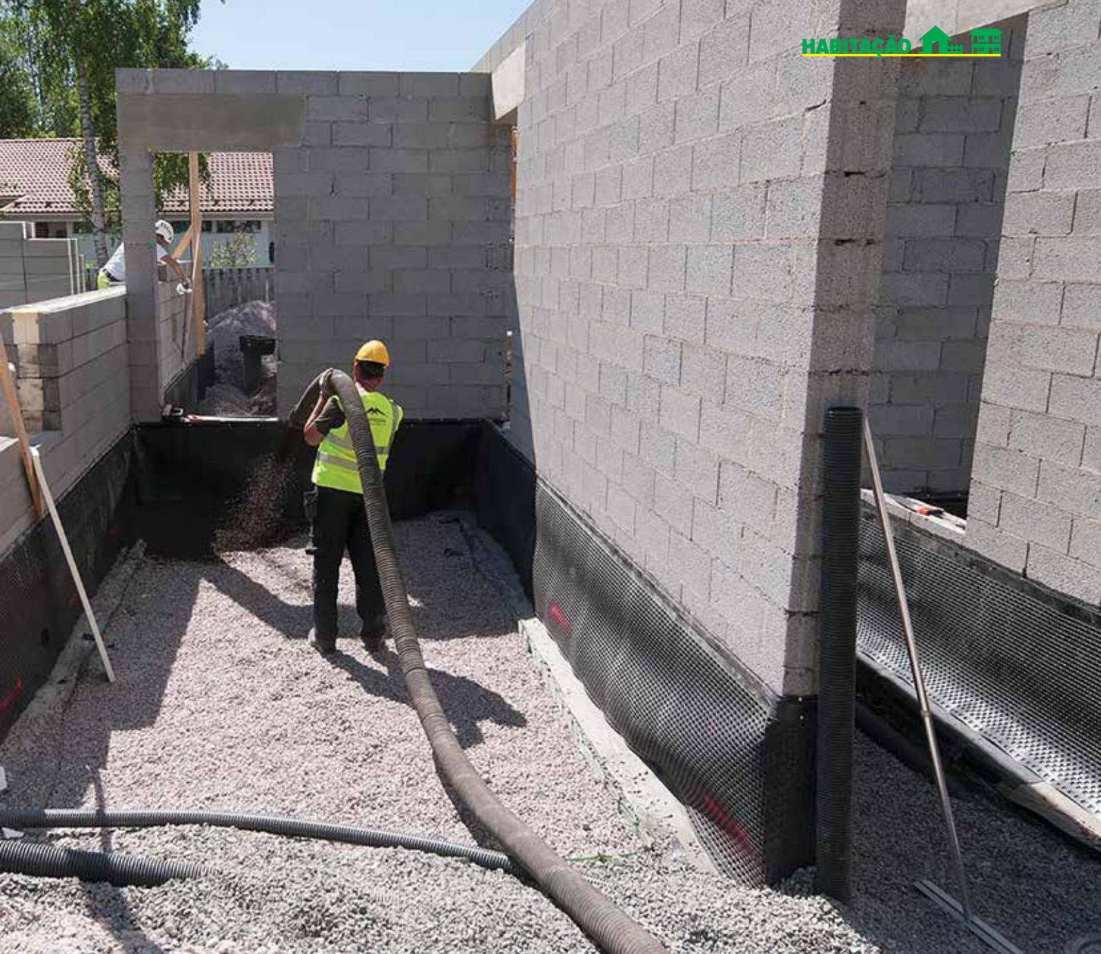
**Foi bombada pneumaticamente** uma camada de aproximadamente 700 mm de agregado leve Leca® nas fundações de cada garagem.
