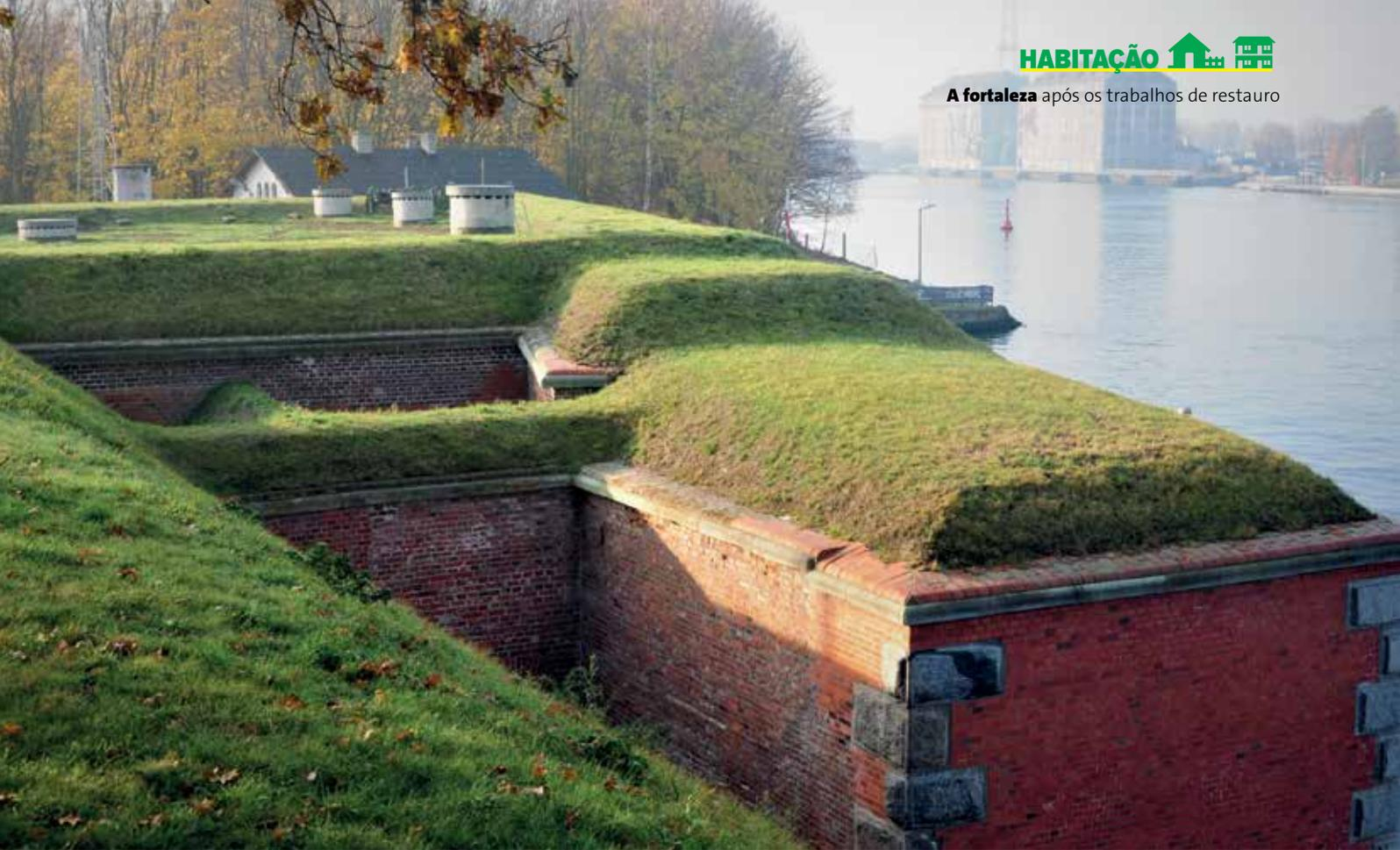
O projeto de recuperação da fortaleza realizou-se em duas fases. Em 2006 foram realizadas obras preliminares, destinadas a aliviar a carga e proteger a estrutura contra a humidade. Posteriormente, em parte da superfície das antigas abóbadas de tijolo, o solo usado no aterro foi substituído por agregado leve Leca®. Uma solução que se mostrou eficaz nos 12 anos seguintes.
