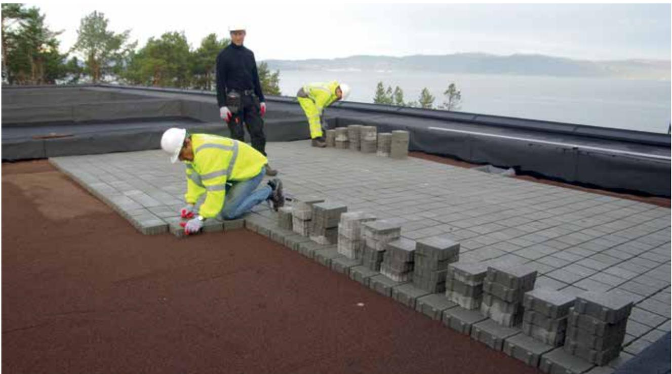
O agregado Leca® britado aplicado sob as lajes no teste de uma solução de lajes absorventes em Høvringen, na Noruega.
