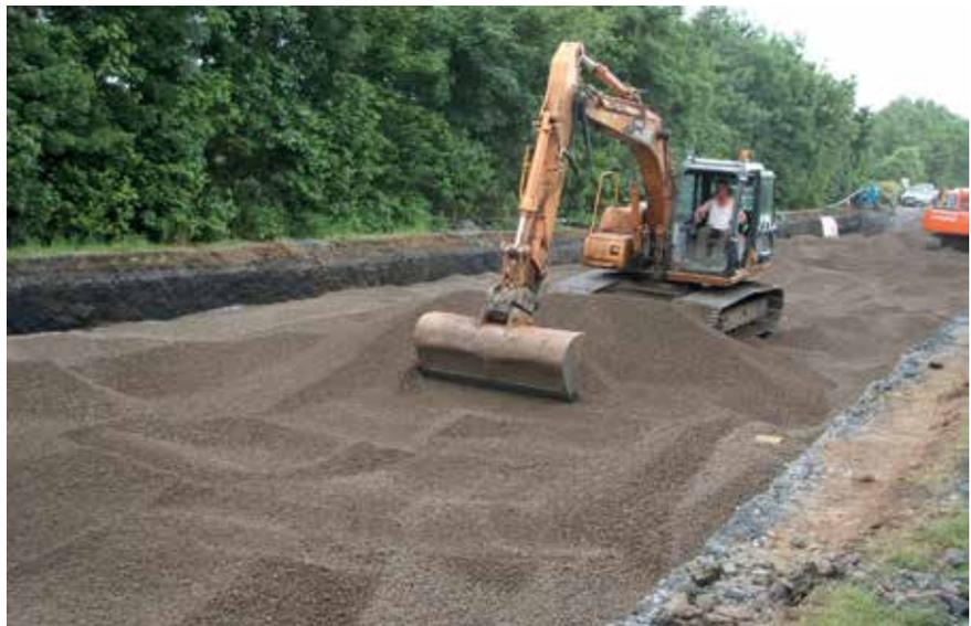
A resistência e as propriedades de compactação do agregado leve Leca® possibilitaram o processo de colocação com recurso a veículos pesados.
