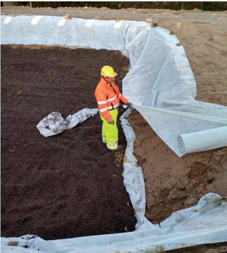
**Colocação de manta** de geotêxtil de polipropileno (250 gr/m<sup>2</sup>).
