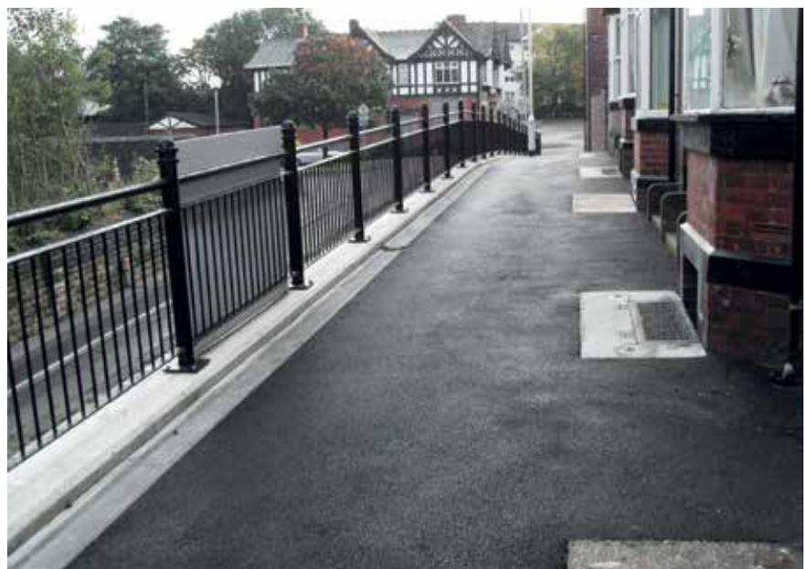
**O agregado leve Leca®** permitiu simultaneamente reduzir a pressão exercida sobre o muro e criar uma plataforma segura para os residentes.
