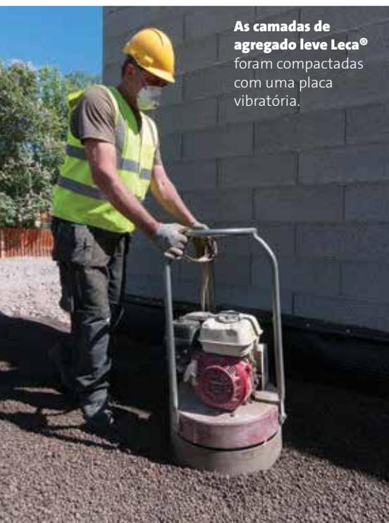
As camadas de agregado leve Leca<sup>®</sup> foram compactadas com uma placa vibratória.
