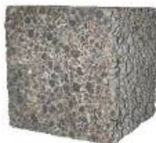
Figura 11 : Aspecto do elemento de alvenaria
