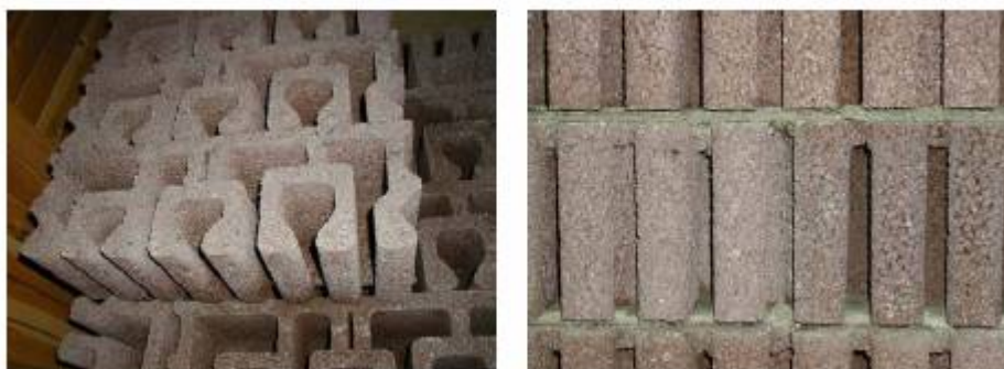
Figura 2 : Aspecto do elemento de alvenaria
