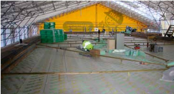
**“O teto híbrido combina** um isolamento térmico eficiente com uma boa ventilação do agregado leve. As excelentes propriedades de ventilação e de resistência contra a humidade do agregado Leca®, bem como a sua capacidade de autossecagem, são significativas na gestão da humidade na construção”, explica Jari Salminen.
