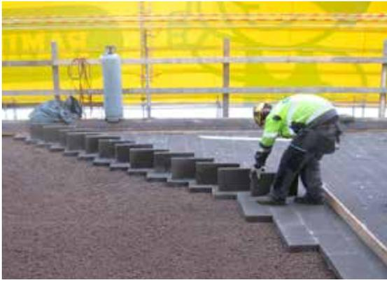
**Como suporte do isolamento** à água, utilizam-se lajetas de cobertura de betão Leca®, em vez de lajetas de betão normal, de 5 cm de espessura, sobre a parte superior do agregado Leca®, como explica o diretor da obra, Jorma Anttila, da Ruuffi Oy. Ruuffi é o empreiteiro responsável pela recuperação do telhado.
