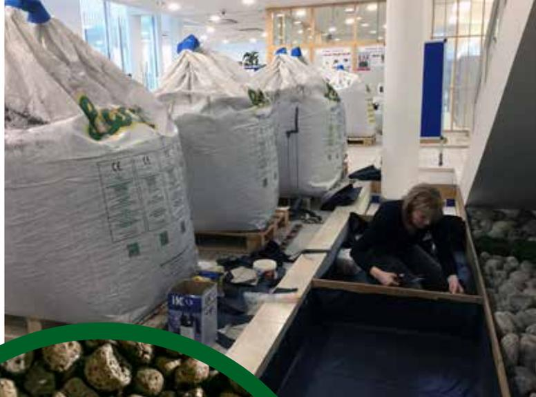
**Arja Rantasalo garante** a impermeabilização dos tanques antes de adicionar o agregado Leca® e a água.
