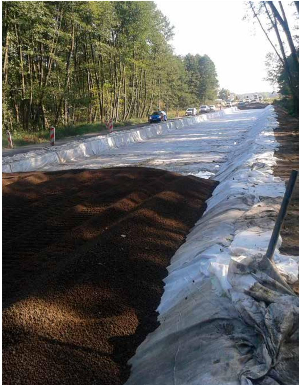
expandida geotécnico envolto numa manta de geotêxtil, e a construção de um talude reforçado (0/63 mm de agregado de pedra esmagada + manta de geotêxtil de álcool polivinílico).
