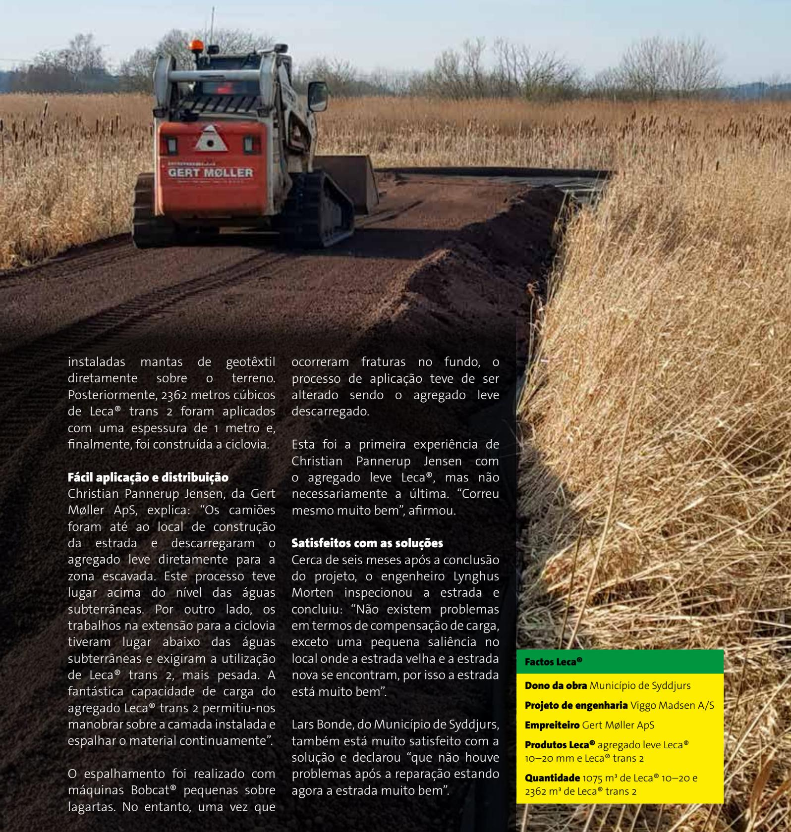
instaladas mantas de geotêxtil diretamente sobre o terreno. Posteriormente, 2362 metros cúbicos de Leca® trans 2 foram aplicados com uma espessura de 1 metro e, finalmente, foi construída a ciclovía.
