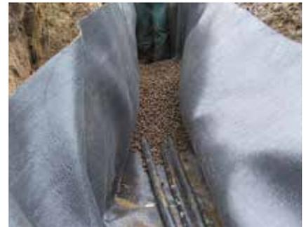
simples de compactação. Todo o material de enchimento foi coberto com geotêxtil, o que tornou o aterro ainda mais robusto e durável e permitiu consolidar a plataforma sobre a qual foi construída a estrada.
