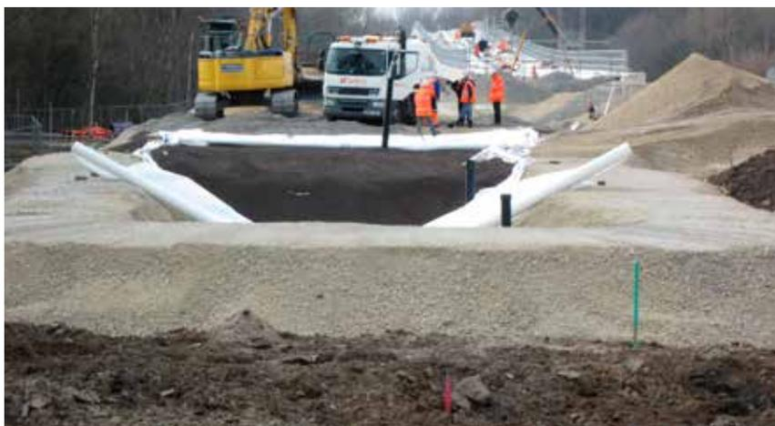
**O agregado leve Leca®** foi especificado para proporcionar um suporte robusto e estável à linha de elétrico.
