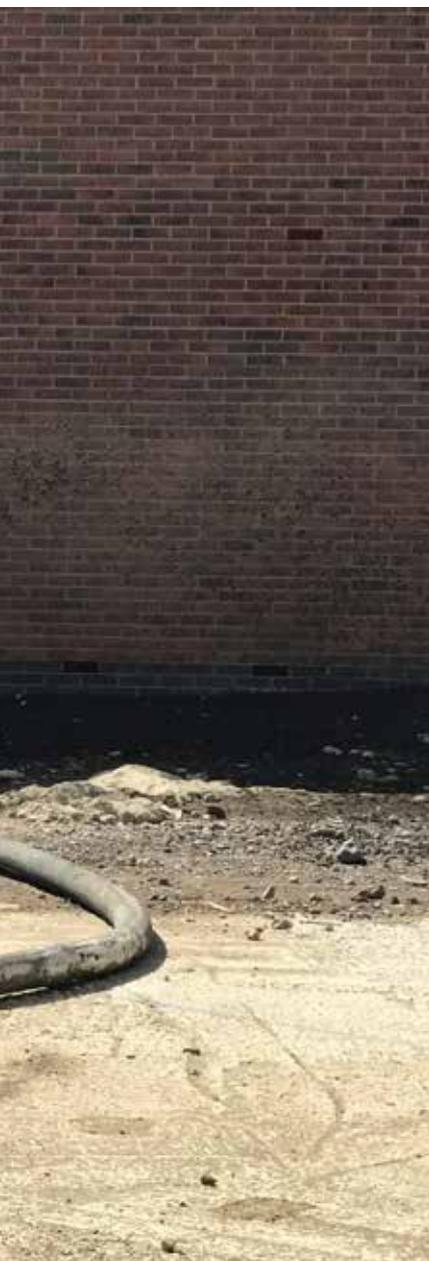
Num grande projeto geotécnico em Warrington, no noroeste de Inglaterra, foi inicialmente proposta a instalação de agregado de betão triturado (MOT/6f2) para criar as fundações de um pátio num novo empreendimento. No entanto, verificou-se que o material era inapropriado, dadas as limitações de acesso ao espaço. O betão triturado teria de ser transportado manualmente em pequenas quantidades através do edifício, o que poderia causar danos.
