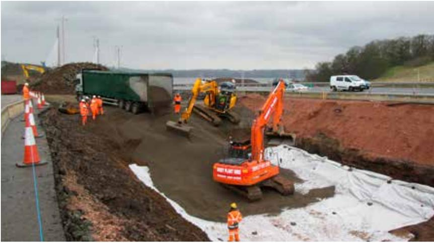
substituição e o enchimento até ao novo nível do projeto. Esta opção resultou na aplicação de uma carga equivalente a zero sobre os estratos moles subjacentes, o que garantiu que o risco de assentamentos pós-construção fosse mantido no mínimo e os problemas de assentamentos diferenciais fossem compensados.
