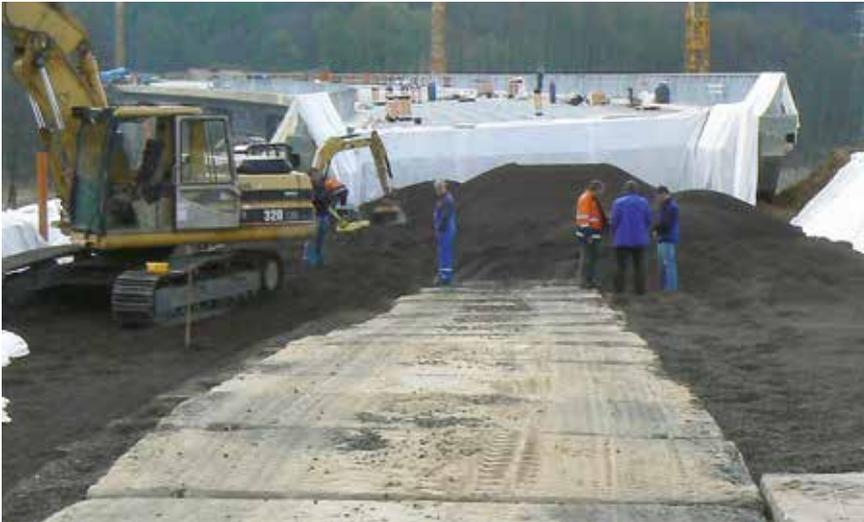
**A estrada e os encontros da ponte** foram construídas com recurso ao agregado leve Leca®.
