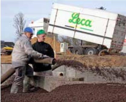
**Instalação fácil** com a entrega do agregado leve num camião com sistema de bombagem.
