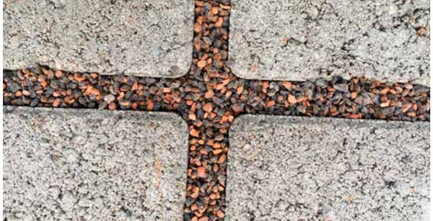
**Os intervalos** entre os elementos de pavimentação foram preenchidos com agregado leve Leca esmagado para garantir desobstrução no fluxo da água.
