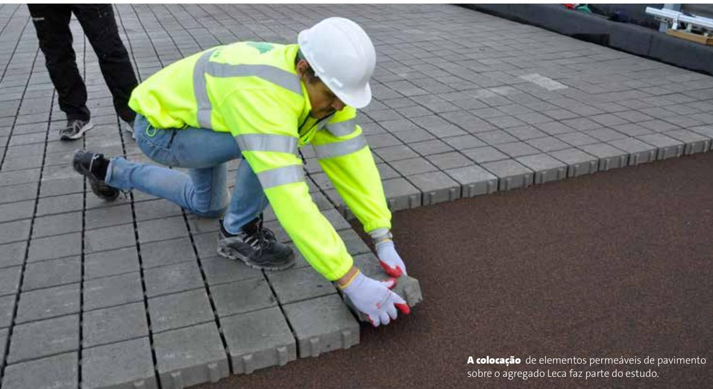
**A colocação** de elementos permeáveis de pavimento sobre o agregado Leca faz parte do estudo.
