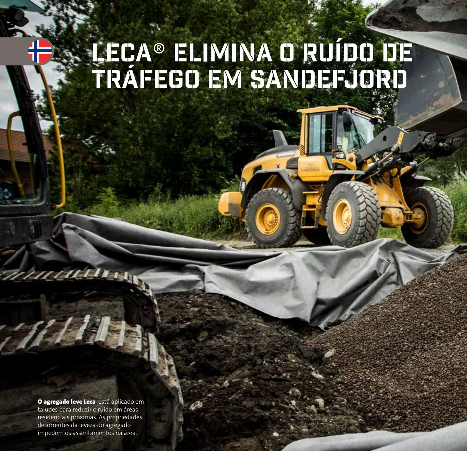
O agregado leve Leca está aplicado em taludes para reduzir o ruído em áreas residenciais próximas. As propriedades decorrentes da leveza do agregado impedem os assentamentos na área.
