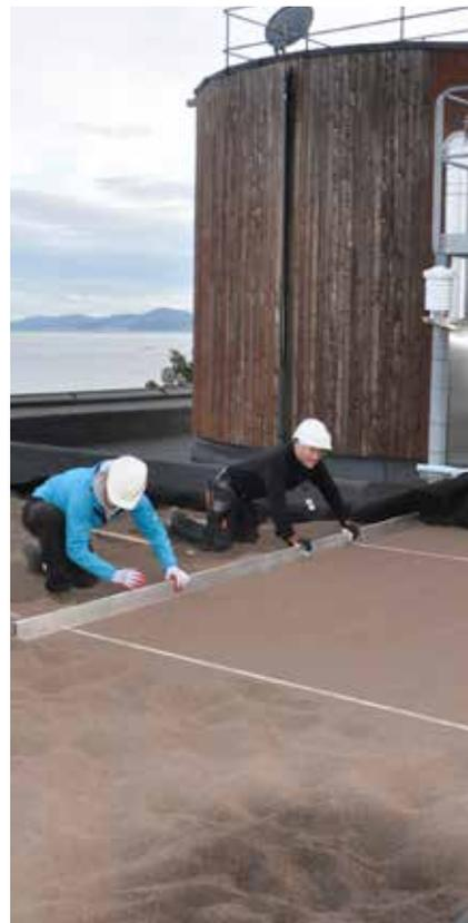
**O material de retenção com Leca fina** foi nivelado com tábua e não através de compactação mecânica.
