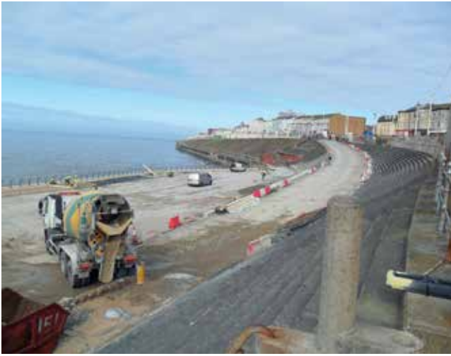
Foram utilizados 4000 metros cúbicos de agregado leve Leca® para o preenchimento do espaço entre as defesas marítimas existentes e o novo paredão.
