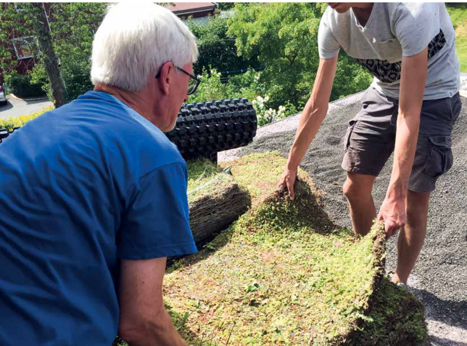
O aglomerado leve Leca® 0-6 mm britado foi usado para maximizar a retenção de água quando Bent C. Braskerud instalou uma cobertura verde na sua casa em Oslo.
