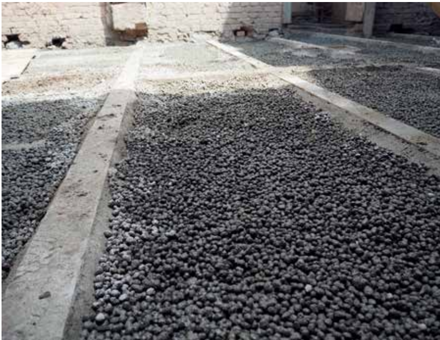
Agregado leve Leca® aplicado no teto entre as vigas.
