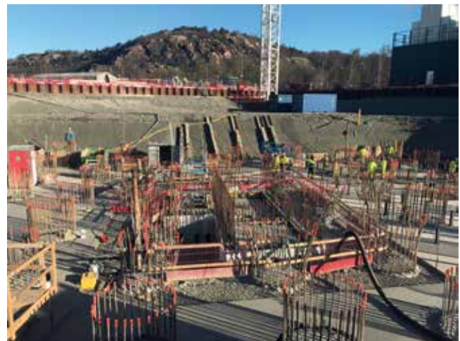
O agregado leve Leca® foi colocado no centro do poço das fundações da torre por caminhão com bombagem pneumática.
