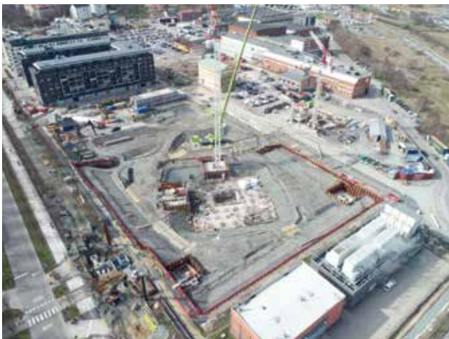
Local de construção do arranha-céus visto de cima.
