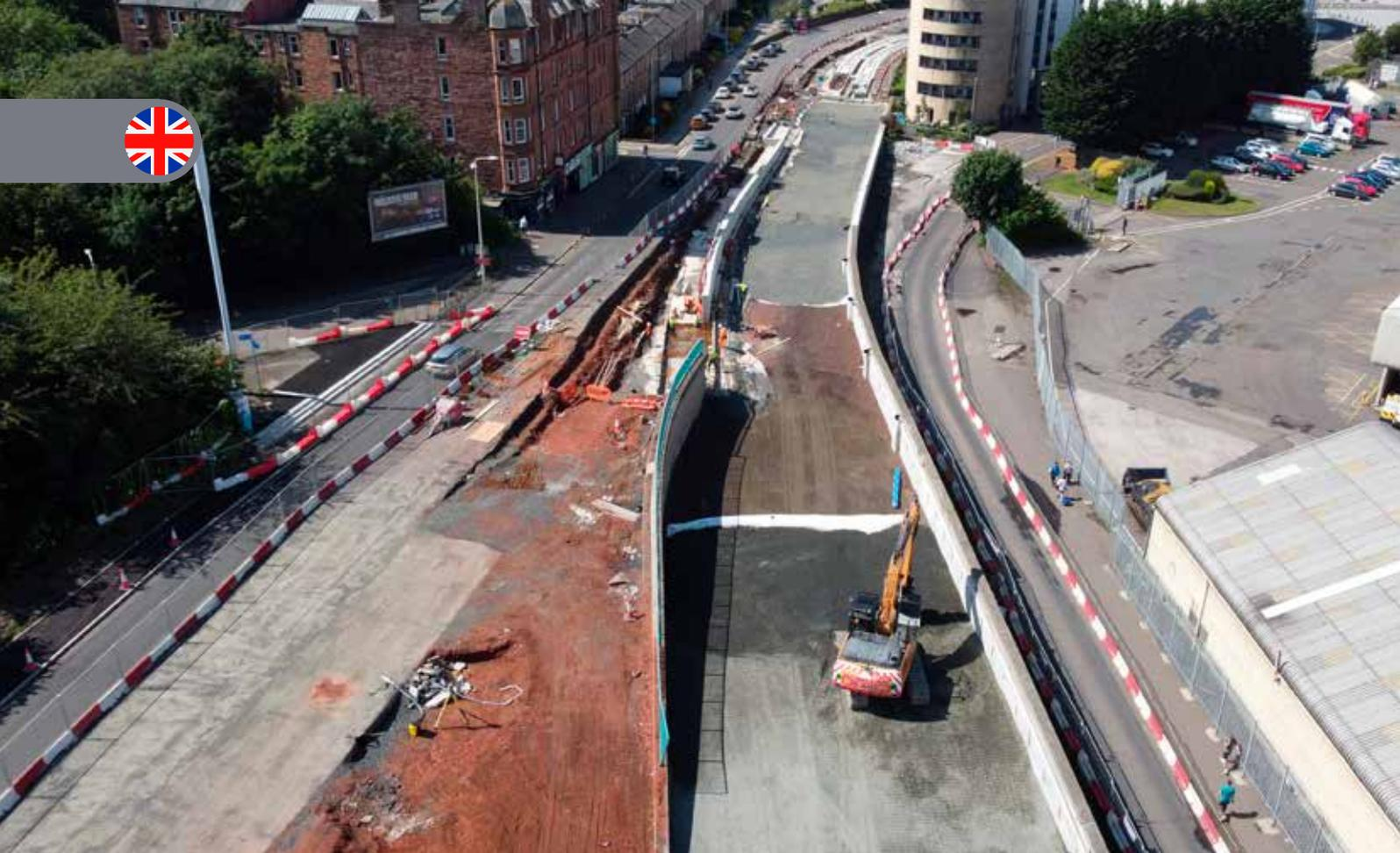
As taxas específicas de compactação do agregado leve Leca® e a capacidade de reduzir a pressão sobre a base foram determinantes
