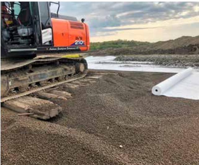
**Foi colocada uma manta de geotêxtil** antes da aplicação do agregado leve Leca®
